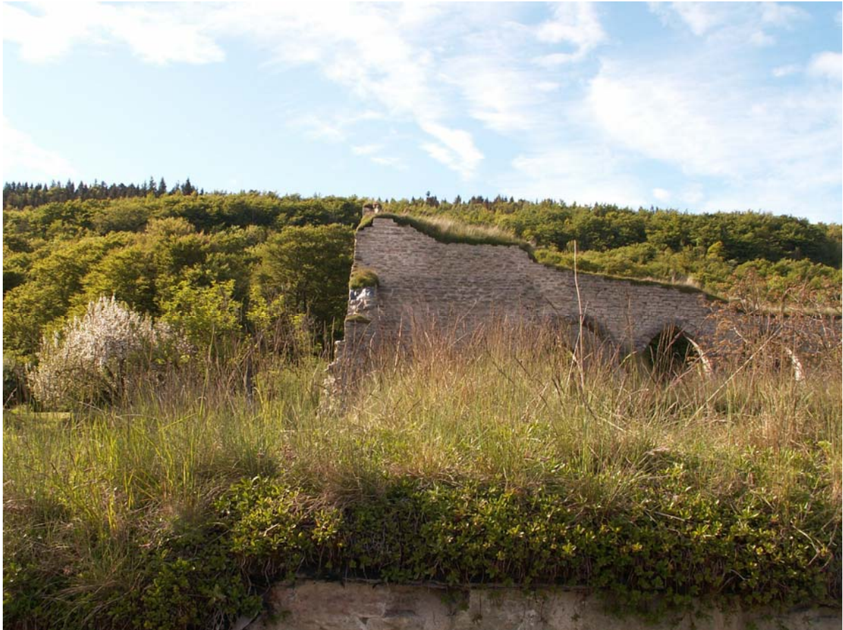
Efter borttagningen är ruinens avtäckningar åter utan träd.
