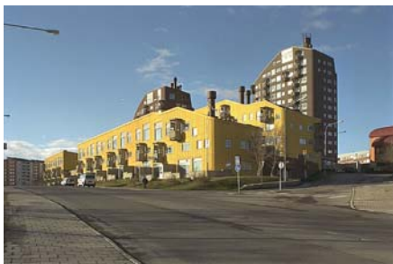
Kiruna centrum, hus ritade av arkitekten Ralph Erskine.
