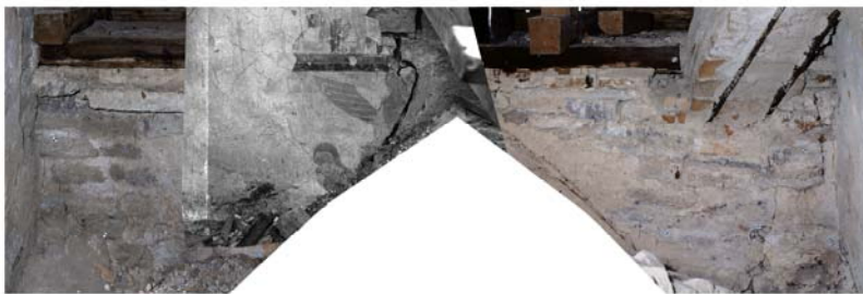
Fig. 13: Murverket/bakgrunden är det rektifierat fotomontage av norrväggens tillstånd 2004. Ovanpå detta ligger ett rektifierat arkivfoto (ATA) från 1900. Denna överlagring visar förlusten av måleriskikt som skedde då väggarna sänktes 1901.
