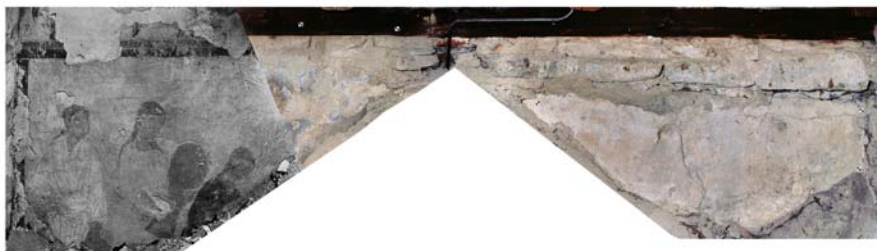
Fig. 15: Murverket/bakgrunden är det rektifierade fotomontage av sydväggens tillstånd 2004. Ovanpå detta ligger ett rektifierat arkivfoto (ATA) från 1900. Denna överlagring visar förlusten av måleri som skedde då väggarna sänktes 1901.
