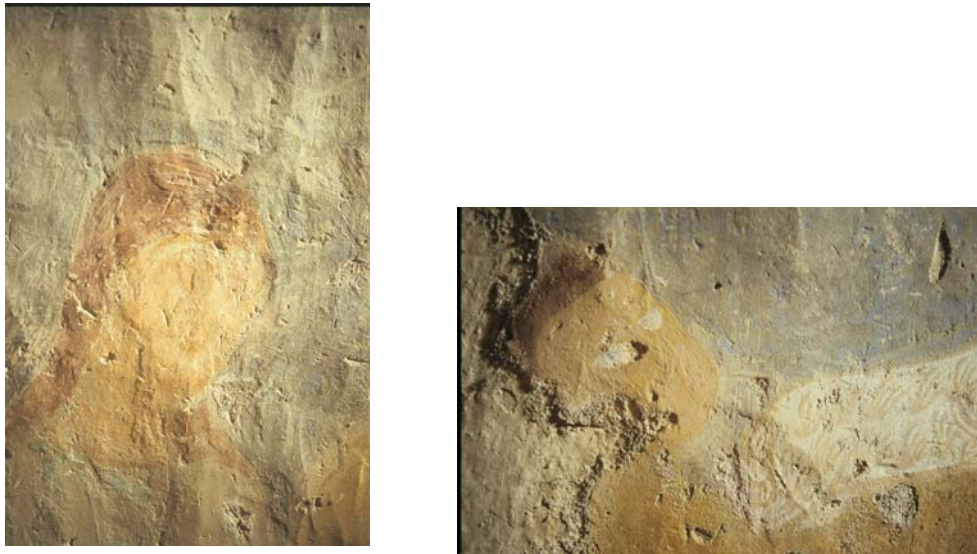
Fig. 23: Bilden till vänster visar en putsskarv i intonacon som löper genom figurens ansikte. Verktygsspår i intonacon är tydliga i kalkmålningens yta, liksom den pastosa karaktär klakgrunderingen har. I båda bilderna ovan syns idag enbart det freskalt bundna färgskikten. Samliga ansiktsdetaljer och modelleringar finns inte bevarade. Den högra bildens bakgrund visar den intensiva blå färgen men en underliggande veneda.
