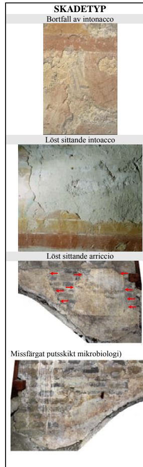
Fig. 5: Del av skadekatalogen för kormålningarna. Detaljfotografierna visar de skador som finns. Dessa skadors fördelning har även lokaliserats med hjälp av kartering.
