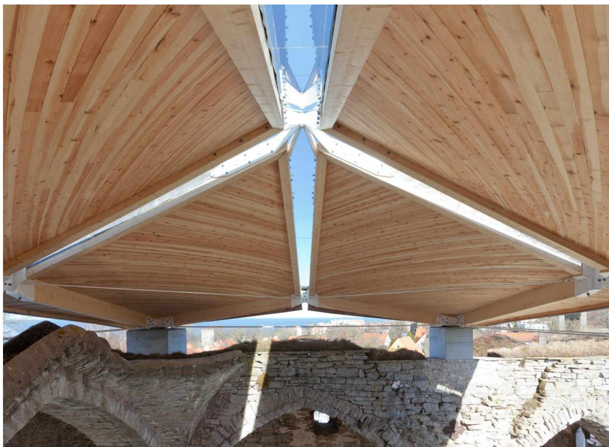
Bild 4.2 Det nya valvet som skapar regnskydd för ruinsalongens bakre del. De infällda glaspartierna låter himlalljuset komma in i ruinen.
