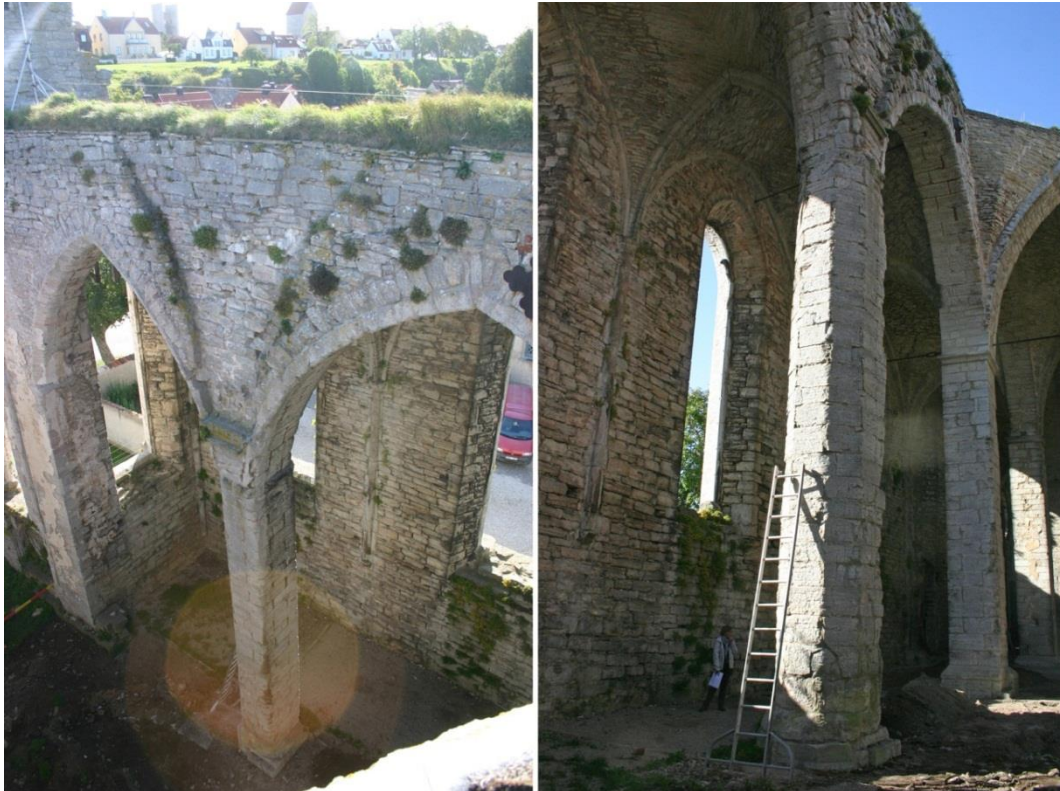
Figur 7.39. Pelare C6. Pelare C6 och B6 har avfasade hörn mot öster.
