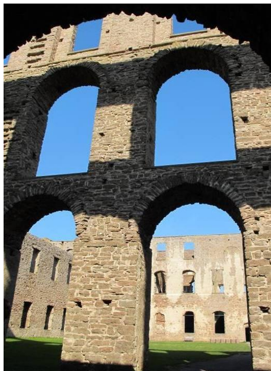
Bild 2.16 Inre borggården vid Borgholms slottsruin. Fönstren i nedre botten i fonden är glasade med ett i det närmsta osynligt specialglas.
