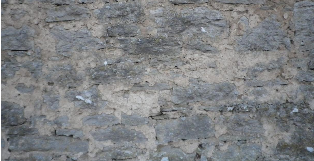
Bild 6.1: Från Visby ruiner syns originalbruk i närbild.
