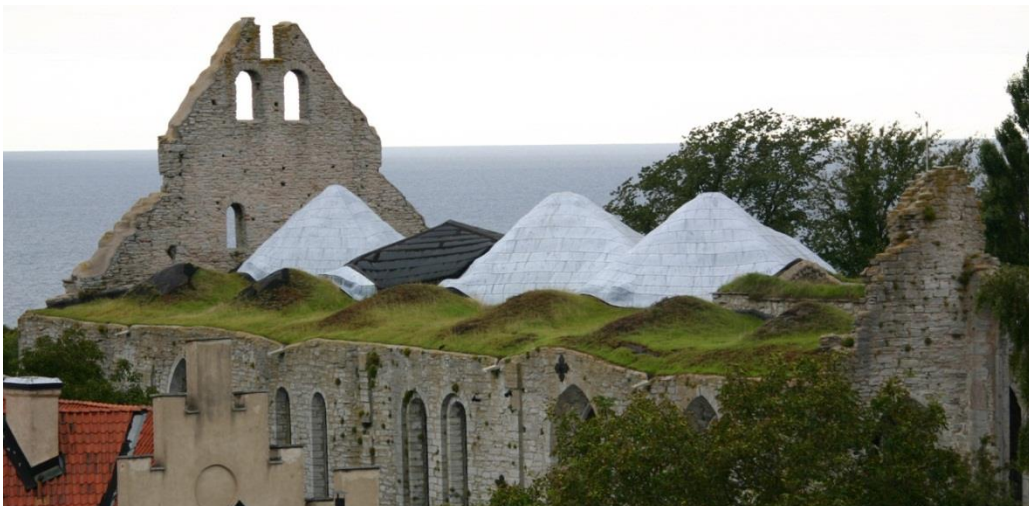
Figur 7.13. Valvens ovansida på kyrkoruinen S:t Nicolai i Visby. Valven är kupolformade och stigande.
