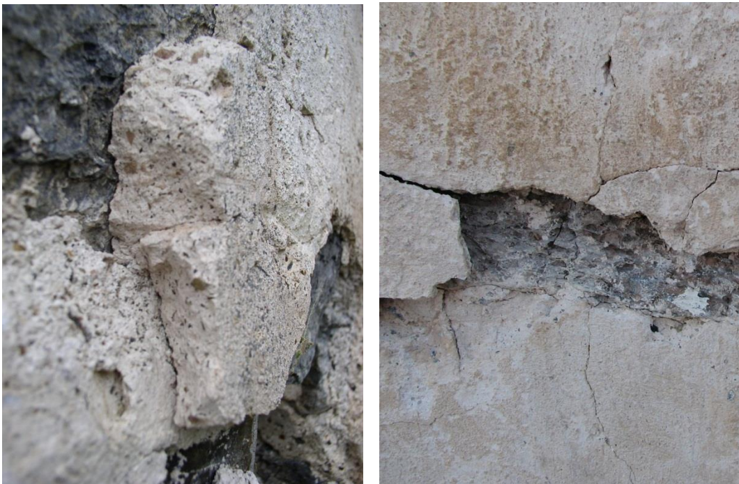
Bild 6.3: Närbilder från putsbruk på Sunne kyrkoruin och Ovikens logårdsmur, båda Jämtland.
