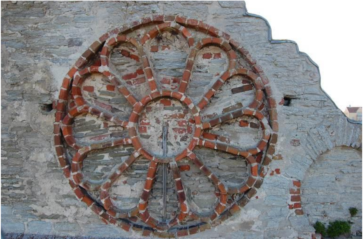
Bild 5.19. Den västra fasaden, detalj av en blinding i tegel. Äldre kalkputsfragment ses både i och runt blindingen på muren. (2009)
