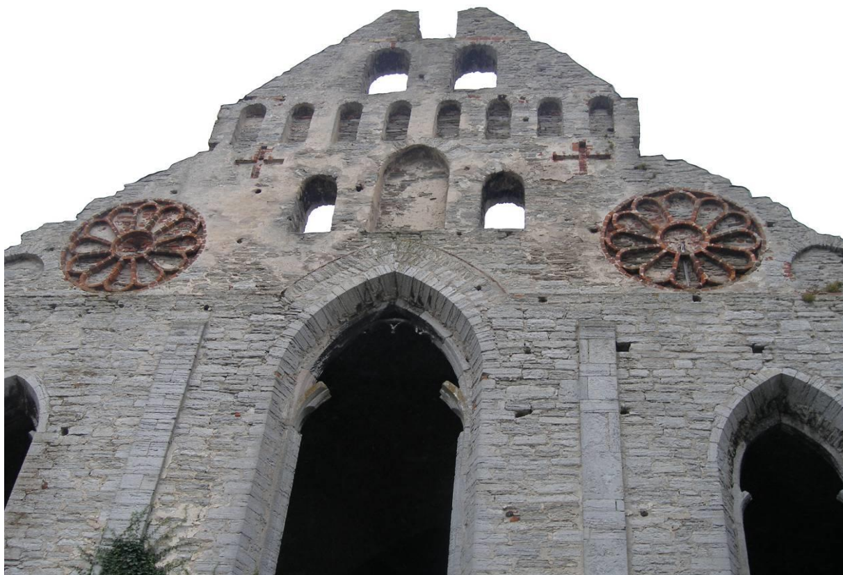
Bild 2.18 Västfasaden på S:t Nicolai ruin i Visby. Kalkstensmurverk och tegeldekorer i form av rosetter och kors.
