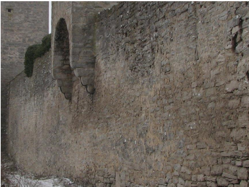
Bild 6.6: I östergravar finns stora mängder originalfogar bevarade på Visby ringmur.
