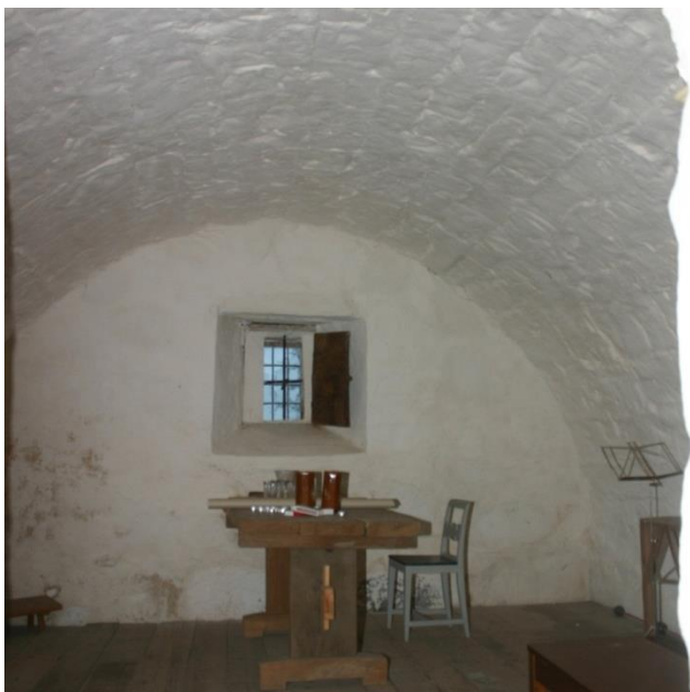
Figur 7.8. Mindre tunnvalv över sakristian i Vederlövs gamla
