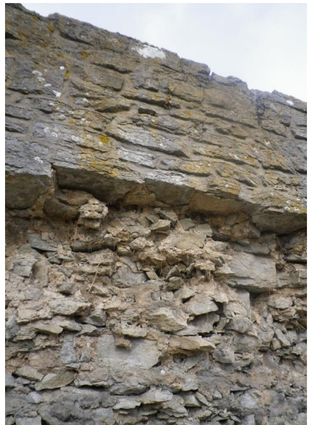
Bild 6.8 Raset på Visby ringmur som inträffade under februari 2012 uppvisar en komplex skadebild. Olika byggnadsfaser innebär stor variation i byggnadsmaterial och byggnadsteknik från början. I nederkant där det finns en murkärna och skalmurar är det olika karaktär på bruket i kärnan och i skalet. Därtill kommer 1900-talets lagningar med täta ytskikt liksom bristande underhåll av växtlighet på murverket.
