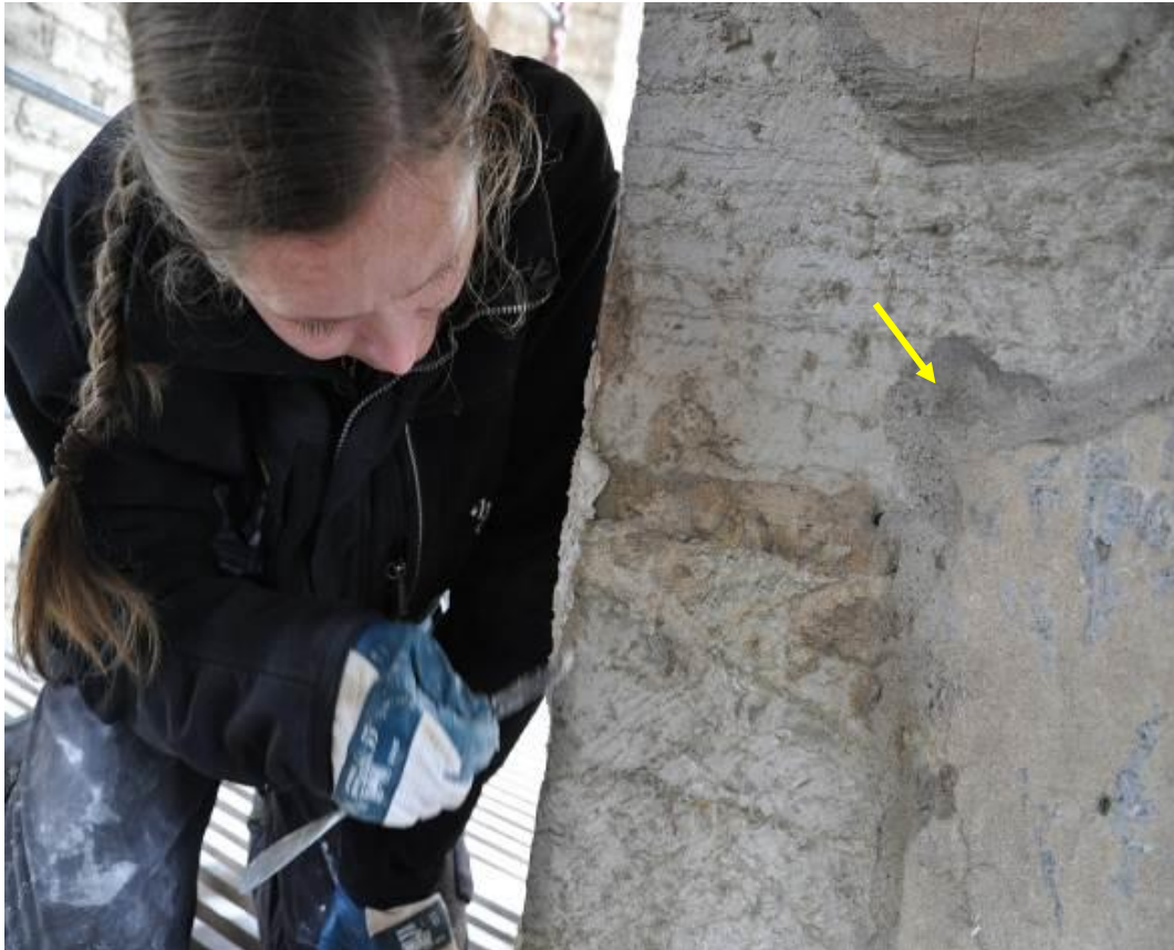
Bild 5.9. Kristin Balksten arbetar med kantförstärkning av löst sittande putsskikt. Till höger i bilden, vid pilen, ses äldre mörka kantförstärkningar i ett hårt bruk.
