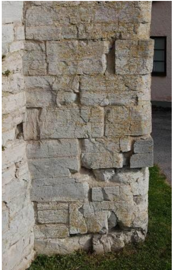
Bild 5.14. En följd av att spjälkande sten inte fixerats vid ett tidigare stadium ses här stora materialförluster. På ytan ses även omfattande lavutbredning. (2009)
