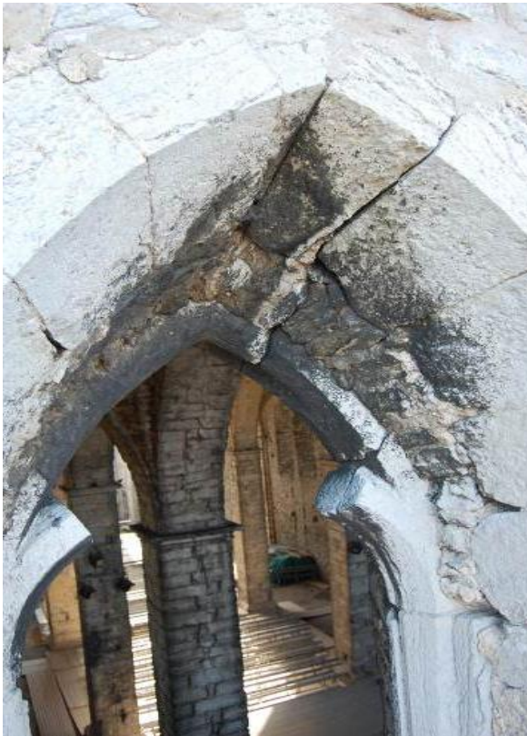
Bild 5.11. Till vänster, sprickbildningar i stenen samt svart beläggning, begynnande krustabildning på stenens yta. Här ses även fogar som vittrat. (2009)
