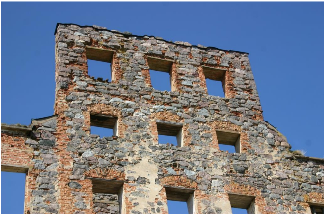
Figur 7.2. Murverk av natursten och tegelsten i blandning. Stjärnorps slottsruin.
