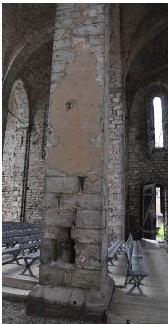
Bild 5.5. Pelare B4 åt norr före åtgärder (2010).
