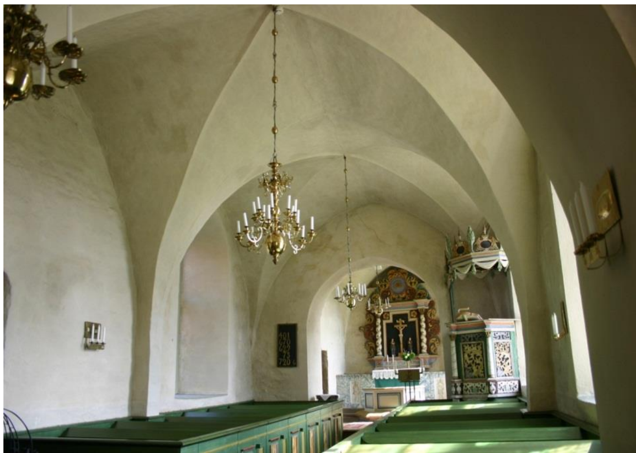
Figur 7.9. Kryssvalv i Marka kyrka.
