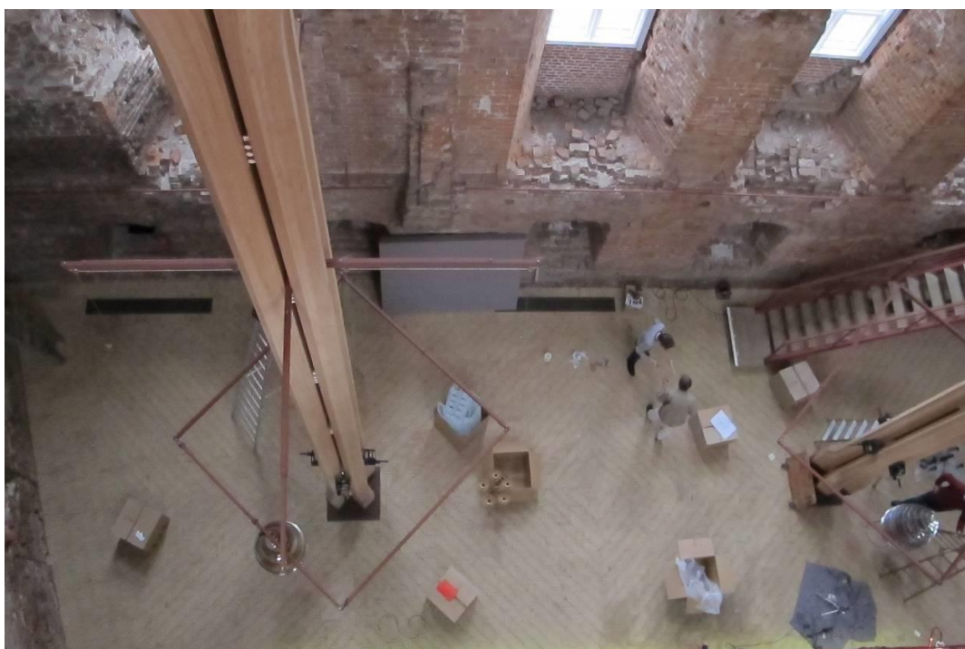
Bild 2.12 Den stora ruinsalen på Koldinghus. Man är i färd med att hänga en utställning om lampor.
