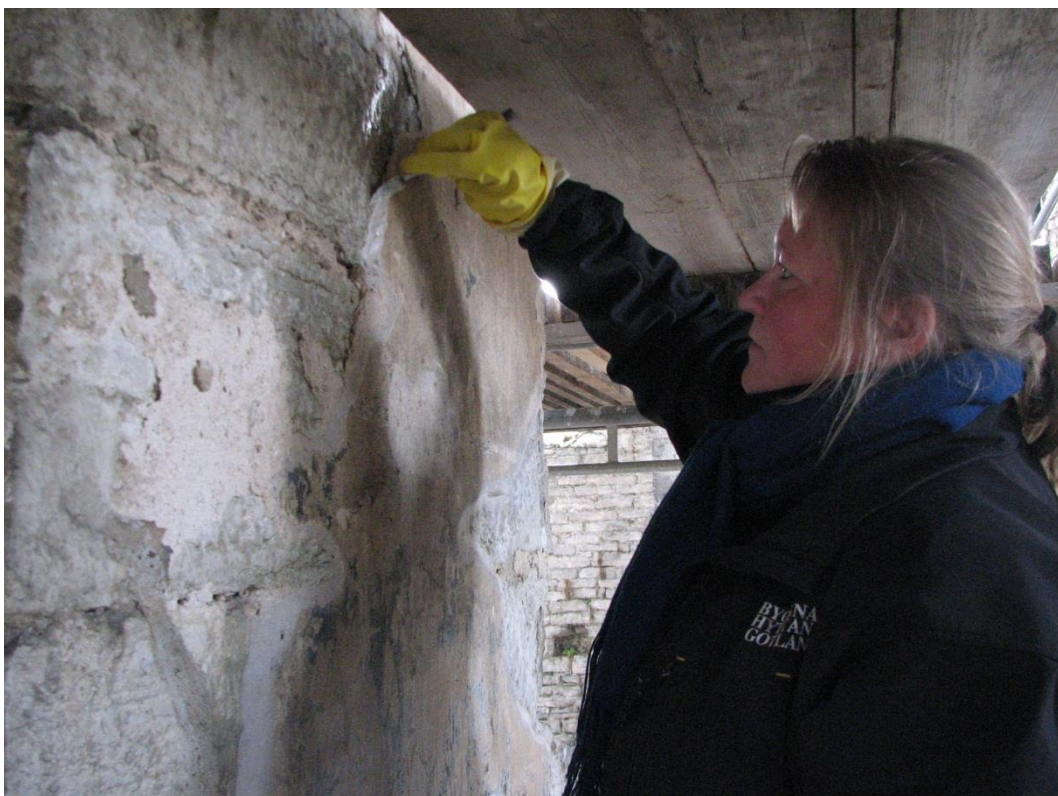
Bild 5.34 Exempel på hur konservator Rebeca Kettunen fäster bemålade putsrester i S:t Nicolai med nytt fett kalkbruk.
