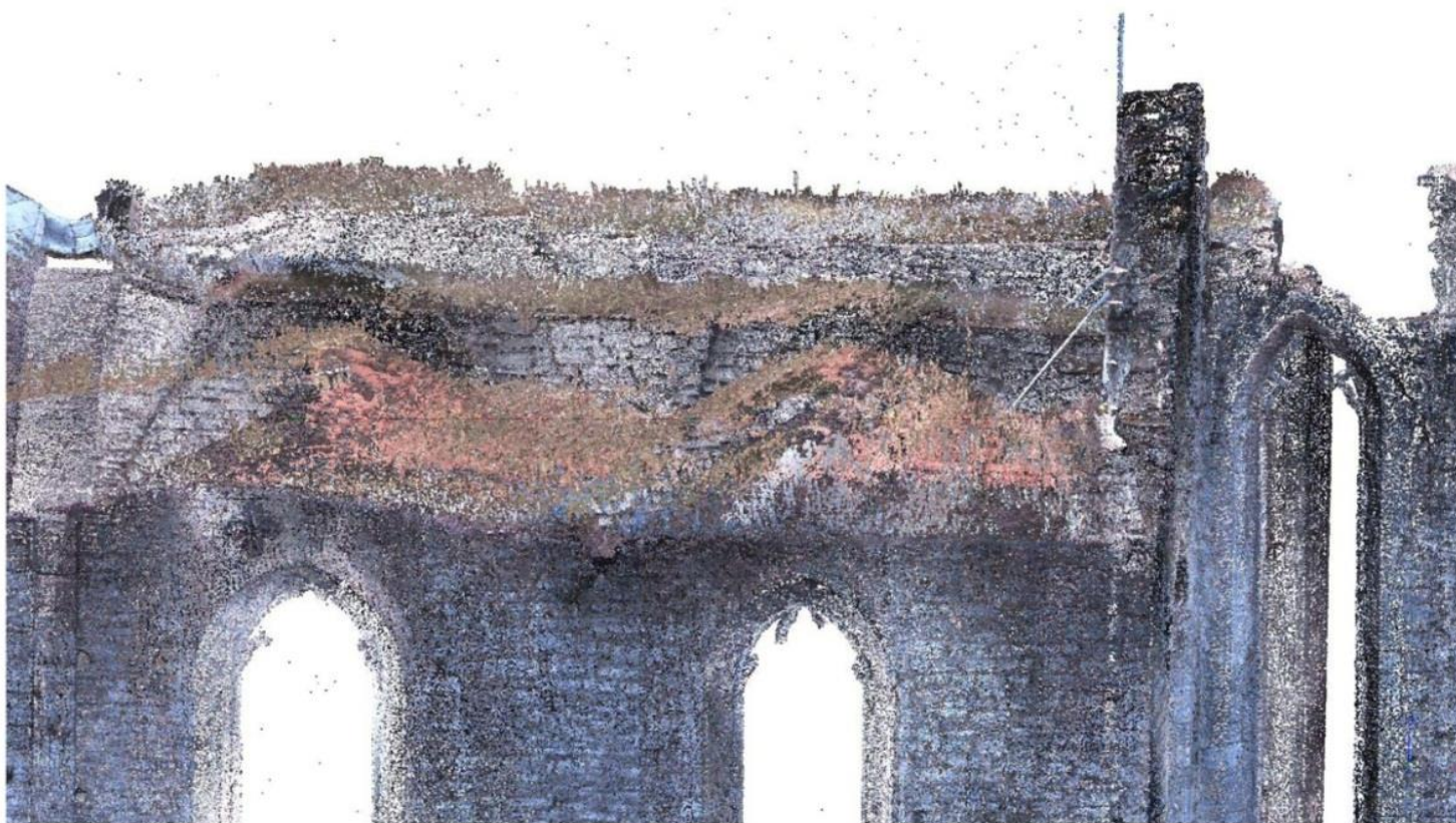
Figur 7.34. Figuren visar ett punktmoln från laserskanningen av S:t Nicolai som importerats till 3DReshaper. Punktmolnet har oklarheter där det växer gräs på ruinens ovensida.
