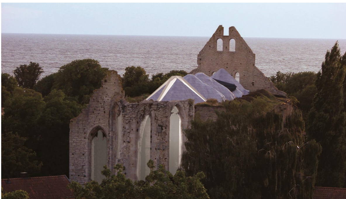
Bild 1.2 S:t Nicolai ruin med det nya valvet, sett uppifrån klinten. Fotomontage: Exners Tegnestue. .2008
