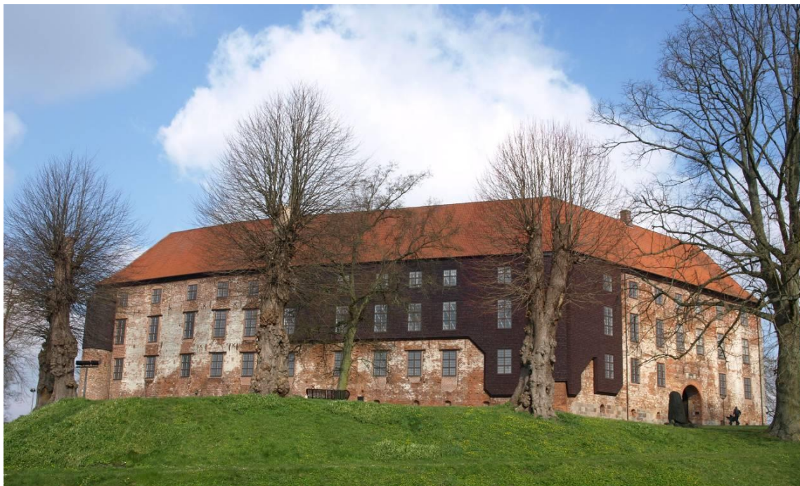
Bild 2.9 Koldinghus i Kolding, Danmark. De mörka väggpartierna utgörs av nya väggsektioner, klädda med tjärade spån, som hänger i den inre, nya konstruktionen och skapar en byggnad av den tidigare ruinen.
