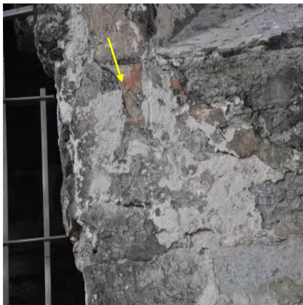
Bild 5.3 och 5.4. Det västra fönstret i travé N2. Bilden till vänster är en orienteringsbild för det bemålade puts-skiktet som ses i den högra bilden. Pilen anger läget för det bemålade putsfragmentet.
