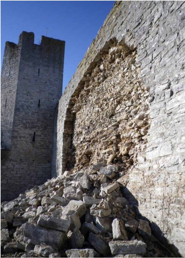
Bild 6.8 Raset på Visby ringmur som inträffade under februari 2012 uppvisar en komplex skadebild. Olika byggnadsfaser innebär stor variation i byggnadsmaterial och byggnadsteknik från början. I nederkant där det finns en murkärna och skalmurar är det olika karaktär på bruket i kärnan och i skalet. Därtill kommer 1900-talets lagningar med täta ytskikt liksom bristande underhåll av växtlighet på murverket.
