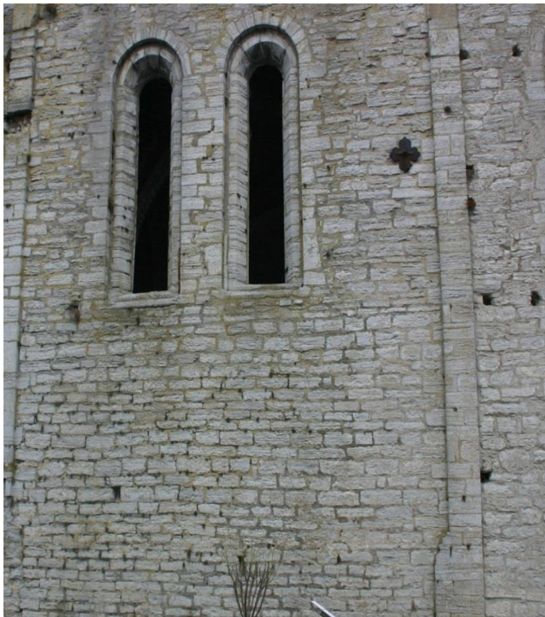
Figur 7.3. Murverk av huggen kalksten. S:t Nicolai kyrkoruin, Visby.
