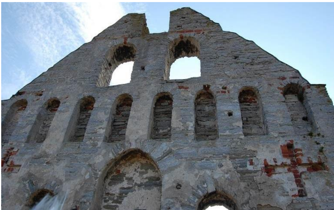
Bild 5.12. Den västra fasaden med blindingar. På murytan ses fragment av äldre putsstikt samt inslag av tegel. (2009)
