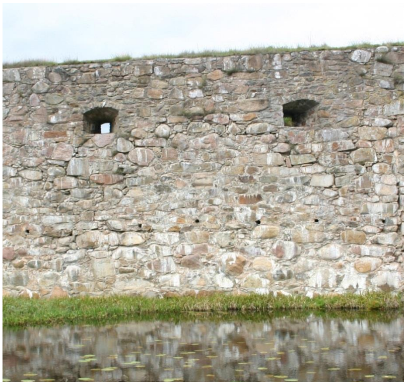
Figur 7.1. Murverk av gråsten. Kronobergs slottsruin.
