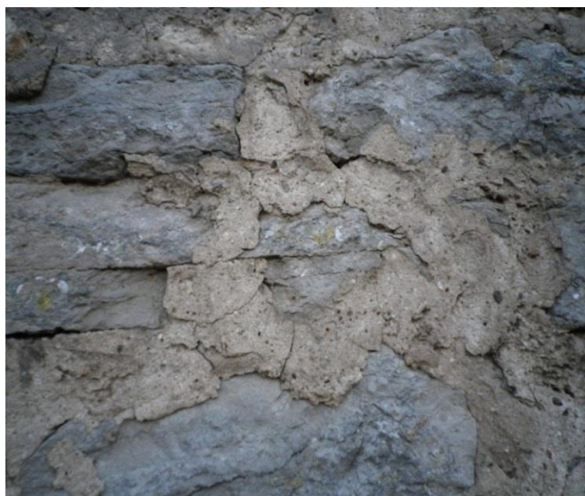
Bild 6.9 a. Fogstrykning utförd på Visby ringmur under workshop september 2011. Utifrån studier av kvarvarande originalfogar diskuterades utförandet och fogarnas ytstruktur. Att fogarna från början varit utstrukna som här bör ha varit bra för uttorkningen. b. Originalfogen är på många ställen bevarad på Visby ringmur och då utstruken på stenen.
