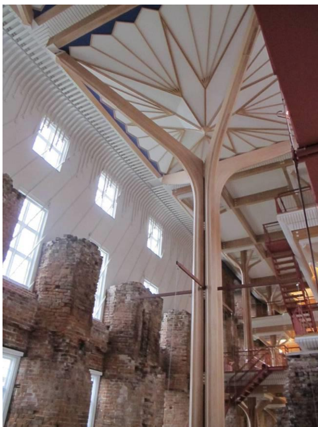
Bild 2.11 Interiör från den tidigare ruinlängan med dess dominanta nya tillägg i form av pelare och nytt tak och väggpartier som vilar på pelarkonstruktionen och inte är förbundna med det gamla murverket.
