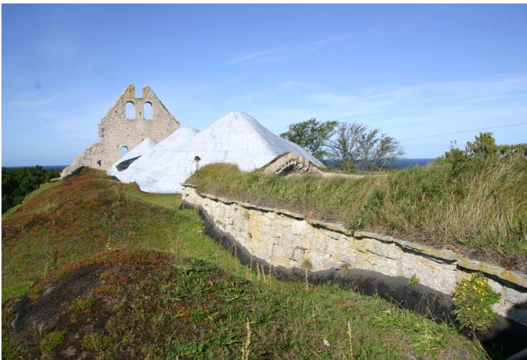
Figur 7.38. Valvens ovansida. Fotot är taget längst i öster mot väster. Till höger i bilden är området där det idag saknas stenvalv och där ett nytt tak av trä och stål finns idag. Fotot visar också att mittvalven är betydligt högre än sidovalven och att valven är tydligt kupolformade vilket innebär att deras hjässa ligger högre än gördel- och sköldbågarnas hjässor.
