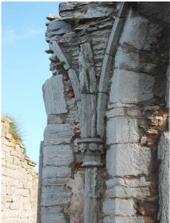
Bild 5.15. Detalj av interiör i koret med bevarat kapital och valvribbor. (2009)
