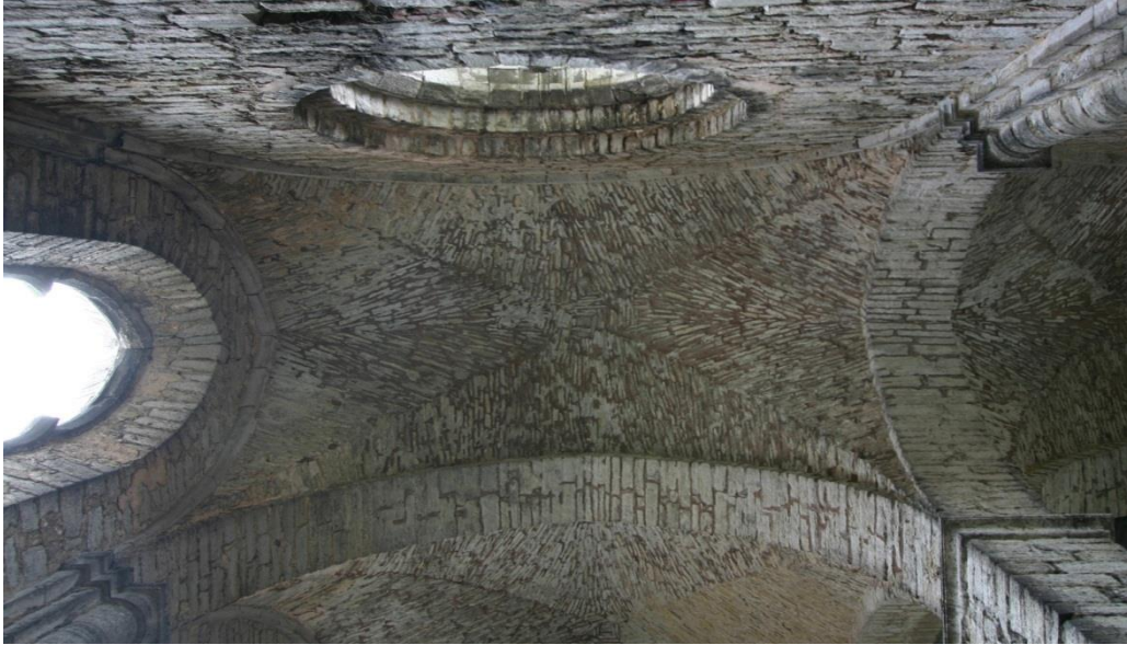
Figur 7.11. Kryssvalv över sidoskeppet i kyrkoruinen S:t Nicolai i Visby. Valvet är mycket stigande vilket innebär att valvkapporna i regel kröker i mer än en riktning.
