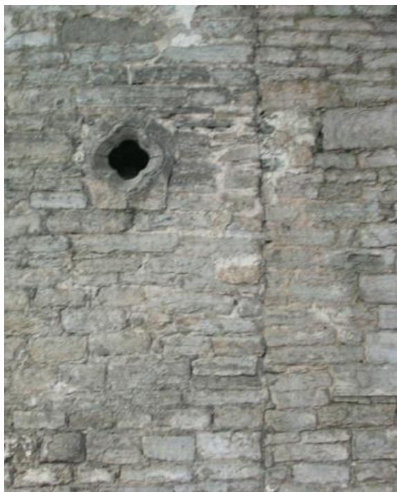
Bild 3.2 Støtfog i nordvästra långhusväggen som visar på förlängningen av kyrkan åt väst.
