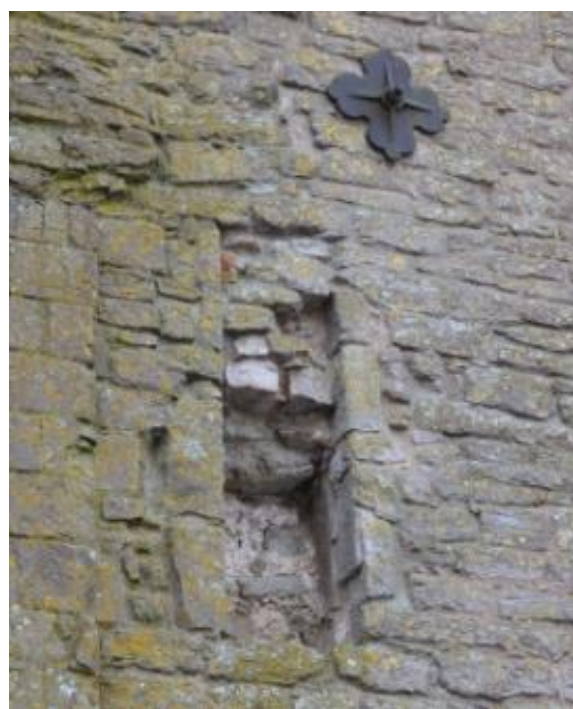
Bild 3.3 Tidig (medeltida?) igensättning av muröppning samt insättning av ankarjärn (1860-tal) i långhusets östra del.
