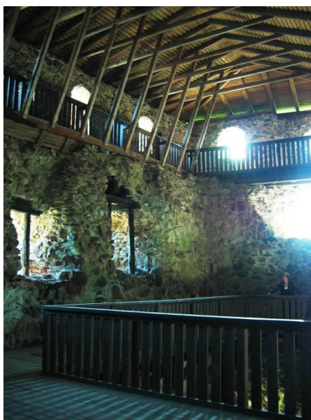
Bild 2.14 Ruinen interiört. Nytt tak, nya bjälklag och gallerier har tillkommit för att skydda och för att tillgängliggöra ruinen.
