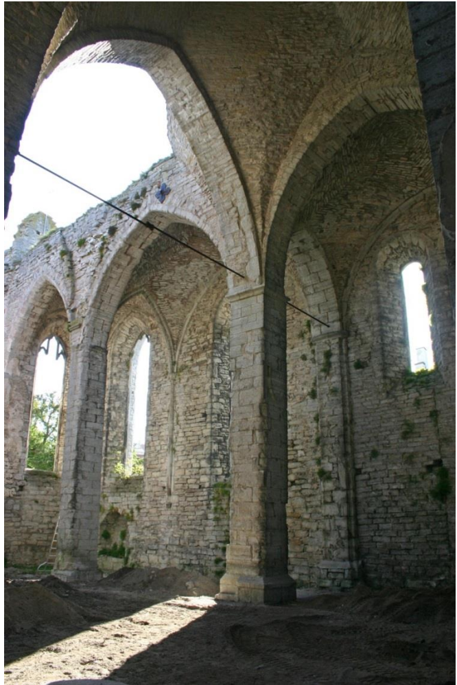
Figur 7.42. Pelare C5 med dragstag.
