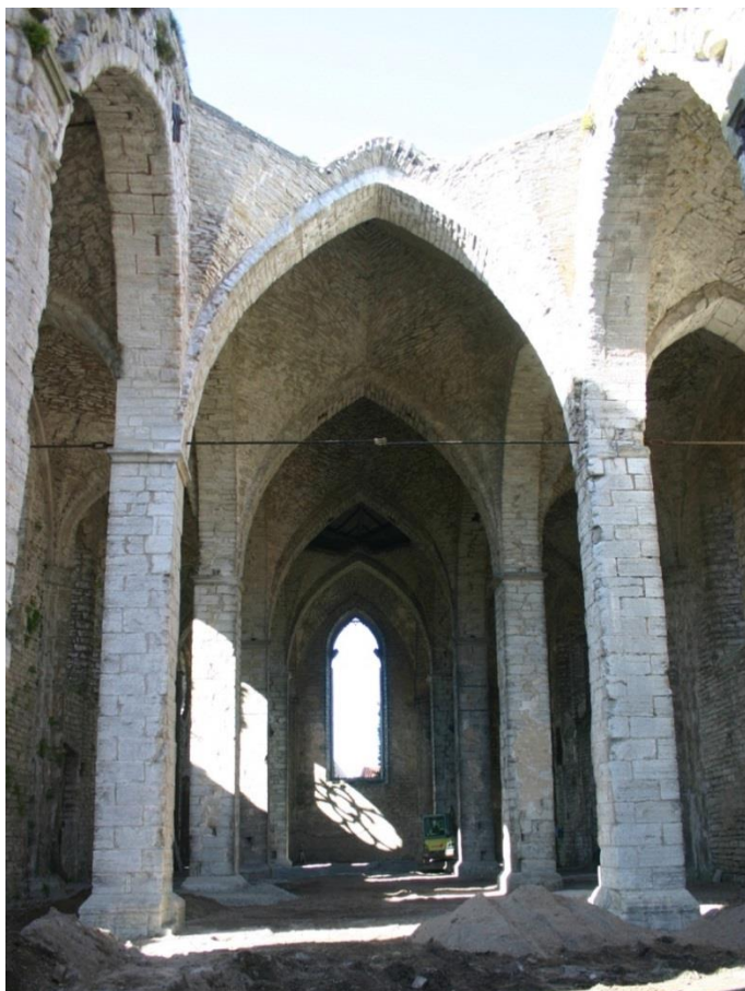
Figur 7.37. Fotot är taget från ruinens östra del, koret, åt väster. Det valv som saknas i bildens överkant är valv M5 som numera är övertäckt med ett nytt tak av trä och stål.
