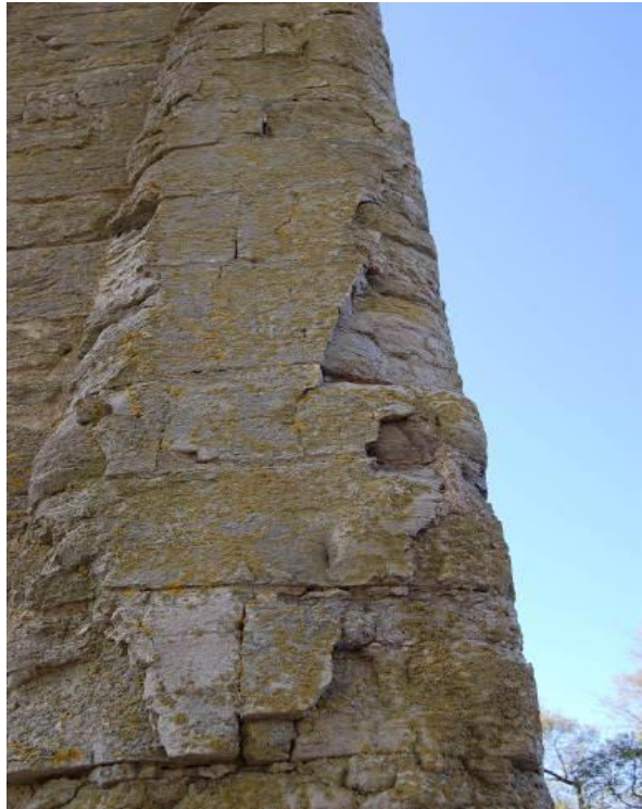
Bild 5.14. En följd av att spjälkande sten inte fixerats vid ett tidigare stadium ses här stora materialförluster. På ytan ses även omfattande lavutbredning. (2009)
