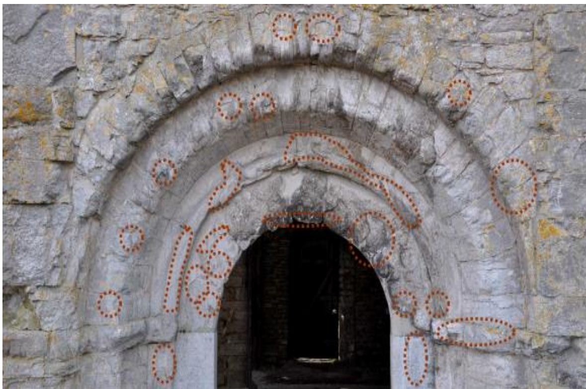
Bild 5.21. Norra långhusportalens arkivolt. De rödmarkerade områdena anger var spjälkande sten fixerades år 2011.
