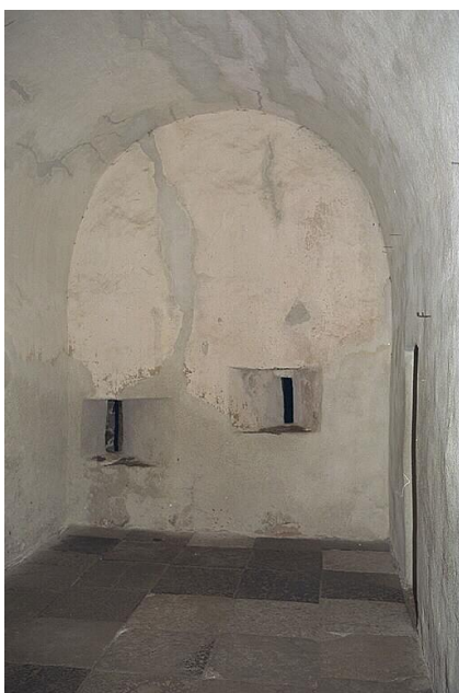
Stugkammaren med skottgluggar och öppning för hemlighus till höger. Foto: Fredrik Nihlén, RAÄ. CC BY
