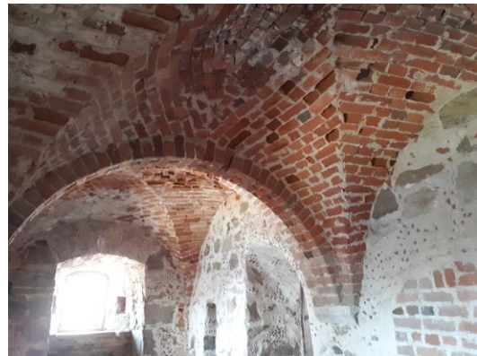
Takvalv i tegel i frustugans stugkammare. Foto: Fredrik Nihlén, RAÄ. CC BY
