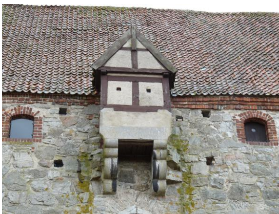
Karnap vilandes på konsoler av sten.
